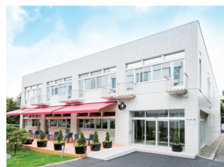
センター棟 ●1F カフェ 11:00~16:00
